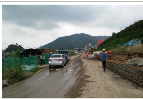
피신청인 공사장 관리 상태(2016.6.15)
