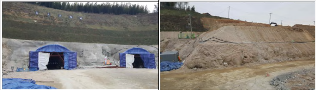
○ 터널 입구 방풍문 설치
